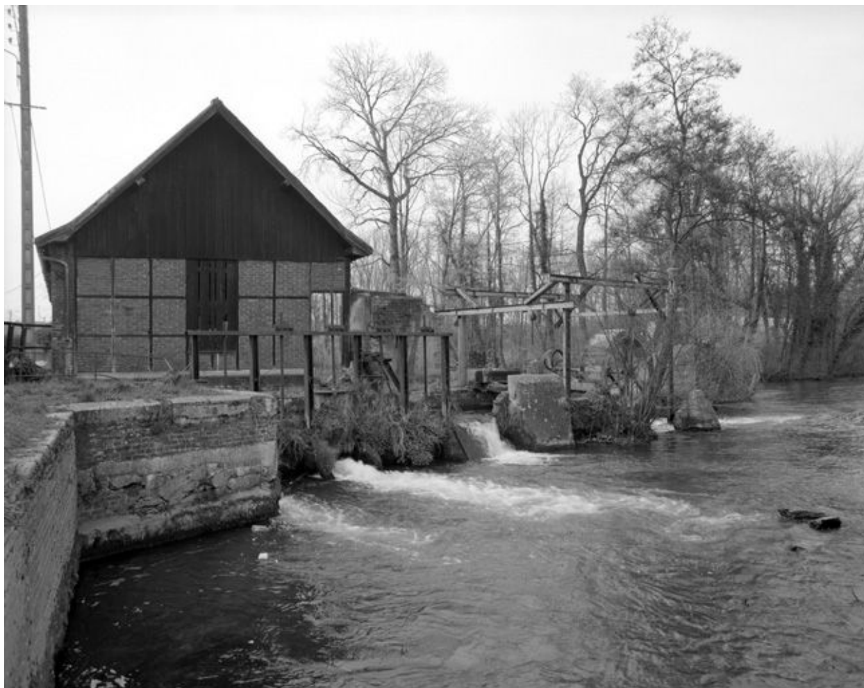
Vanne, roue, vestiges du bâtiment d'eau.
