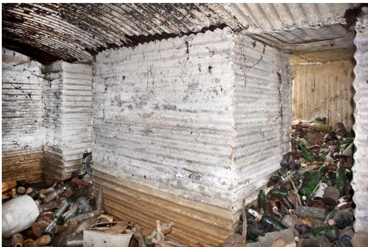
Vue intérieur : le couloir d'enroule autour du pilier de soutènement
