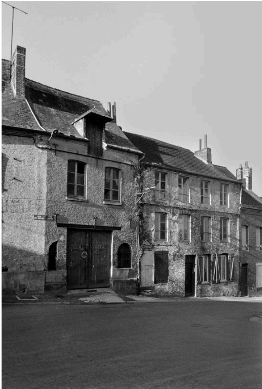
Vue de l'immeuble, depuis la rue des moulins.
