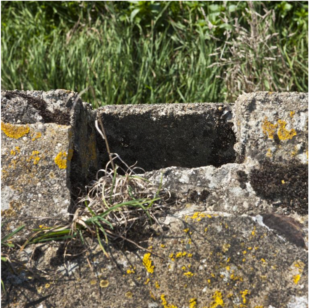
Sortie d'aération de la salle sud-est
