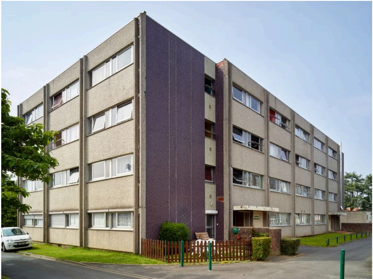
La résidence Descartes depuis le sud-est.
