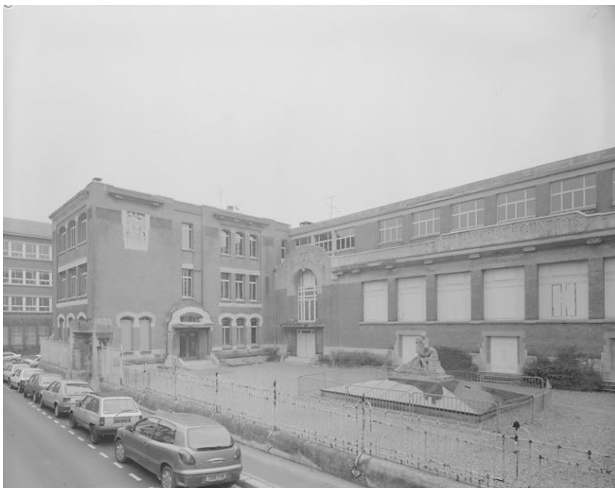
Vue partielle sur la façade rue Deprez.
