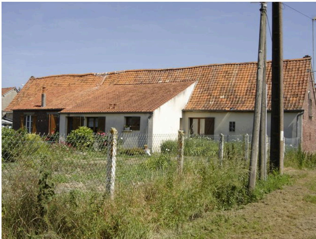
Vue sur la face ouest de l'ensemble.
