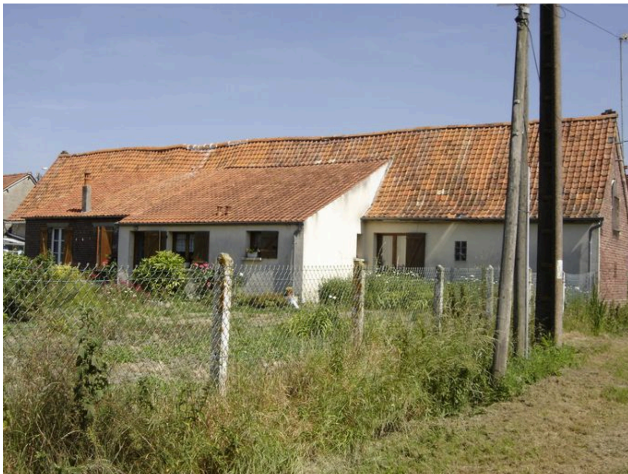
Vue sur la face ouest de l'ensemble.
