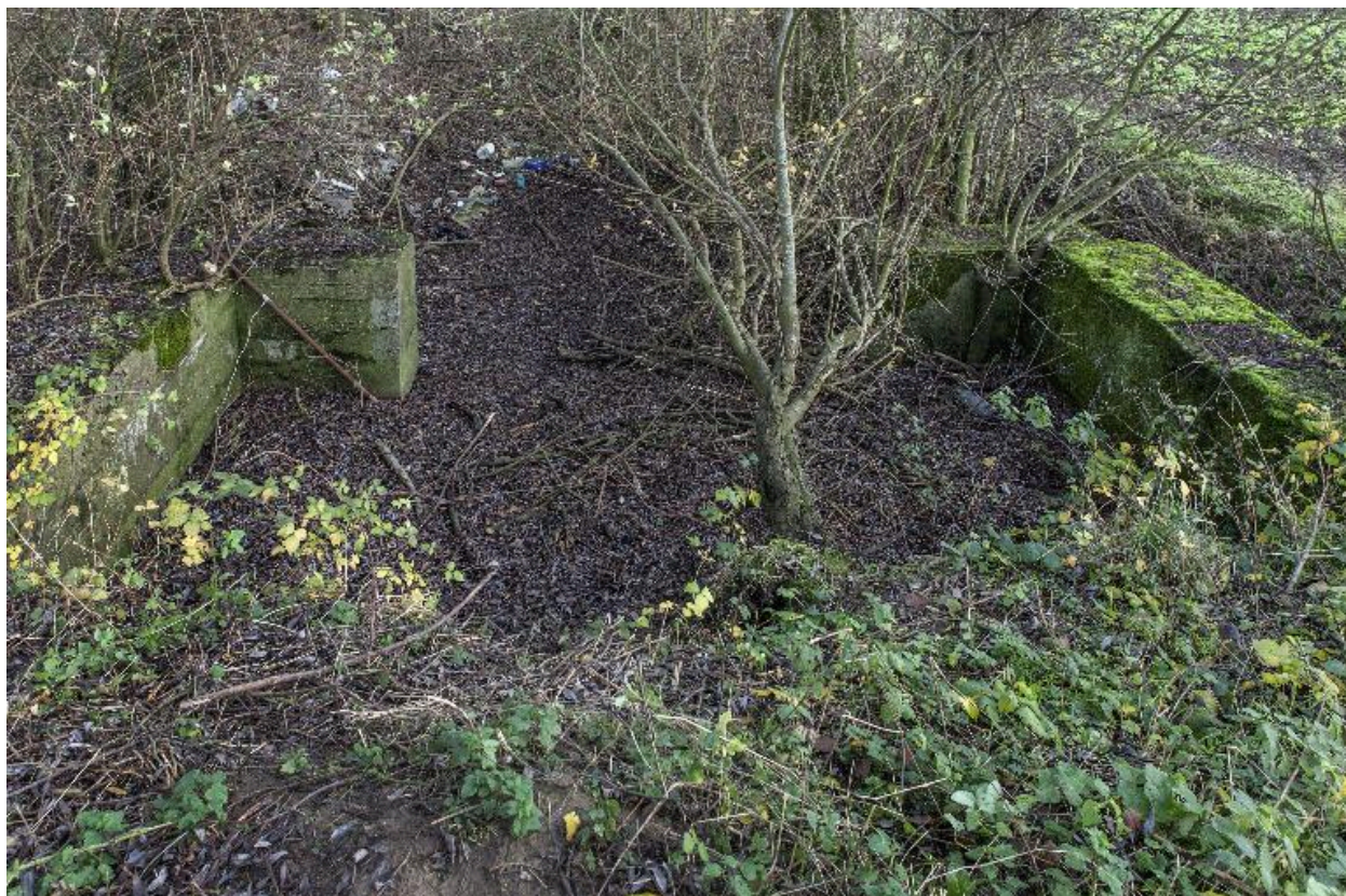
Cuve ouverte entre (88) et (89). Vers le nord-est
