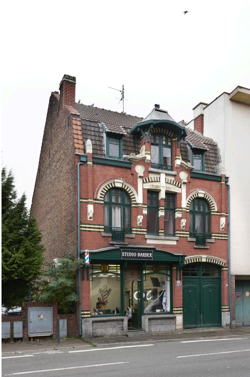
Vue générale de trois quarts avec pignon.
