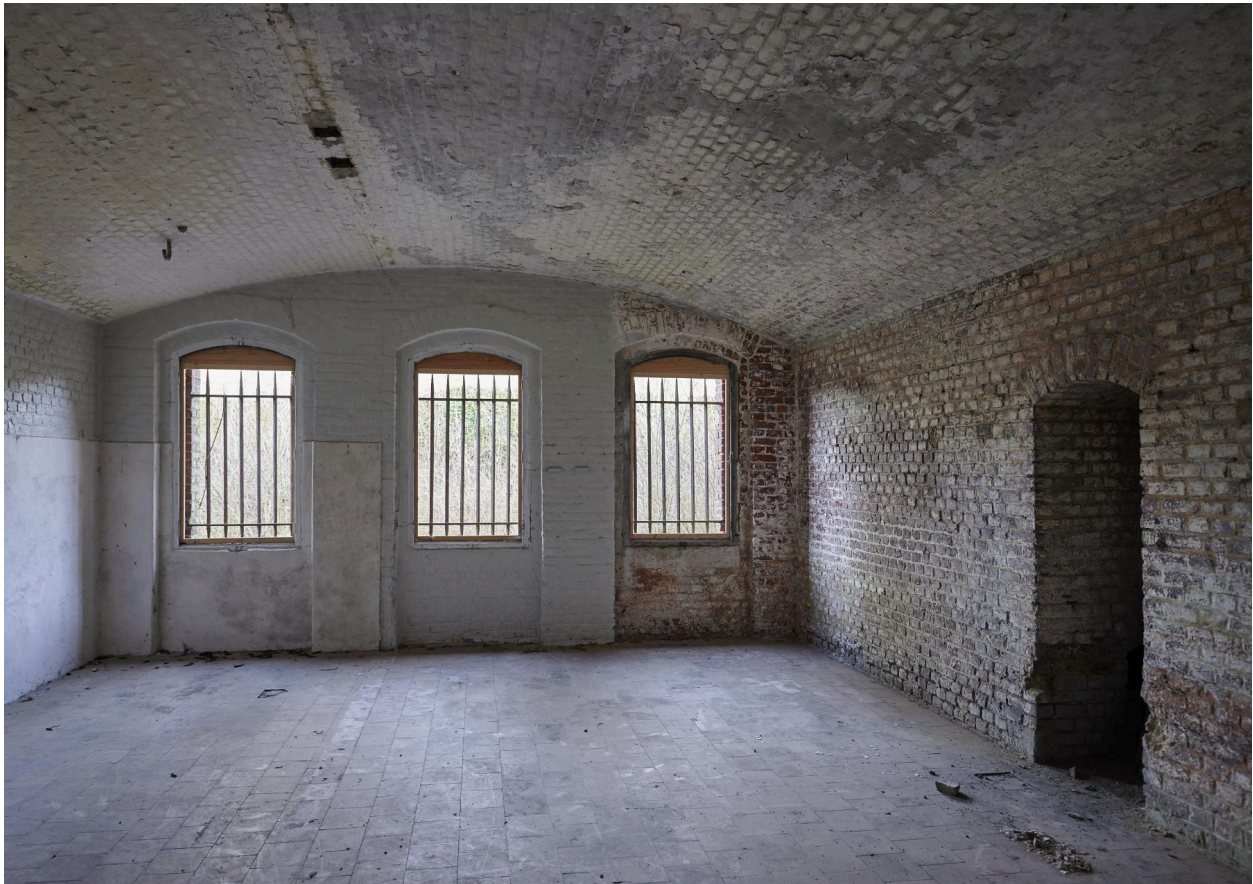
Sous-sol de caserne de gorge. Ancienne tisannerie.
