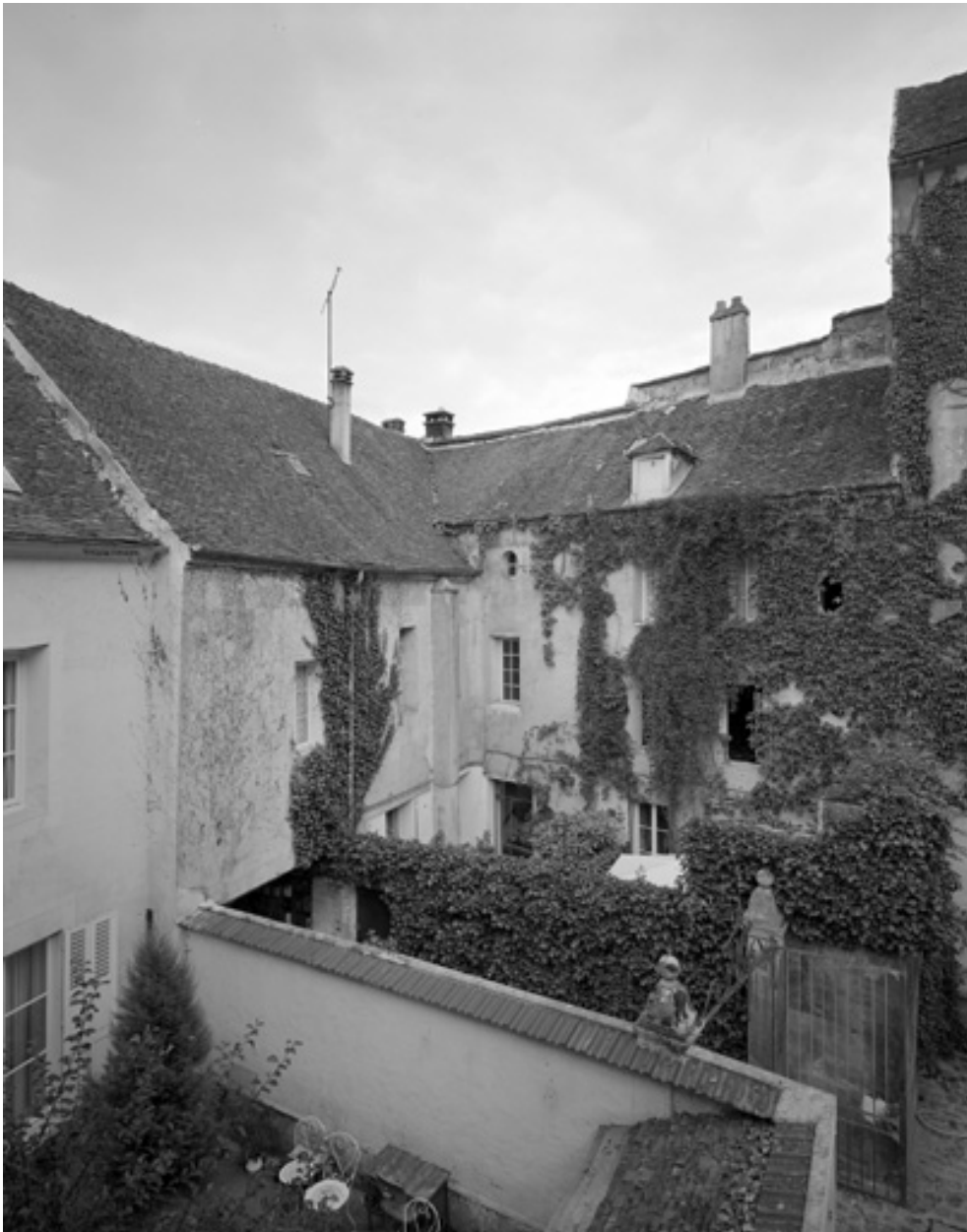
Elévation sur la cour.
