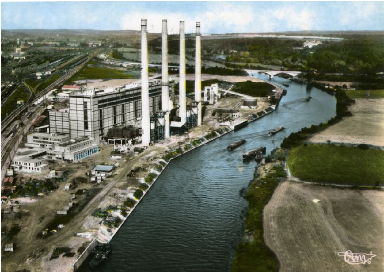
Vue générale de la centrale électrique après sa construction.
