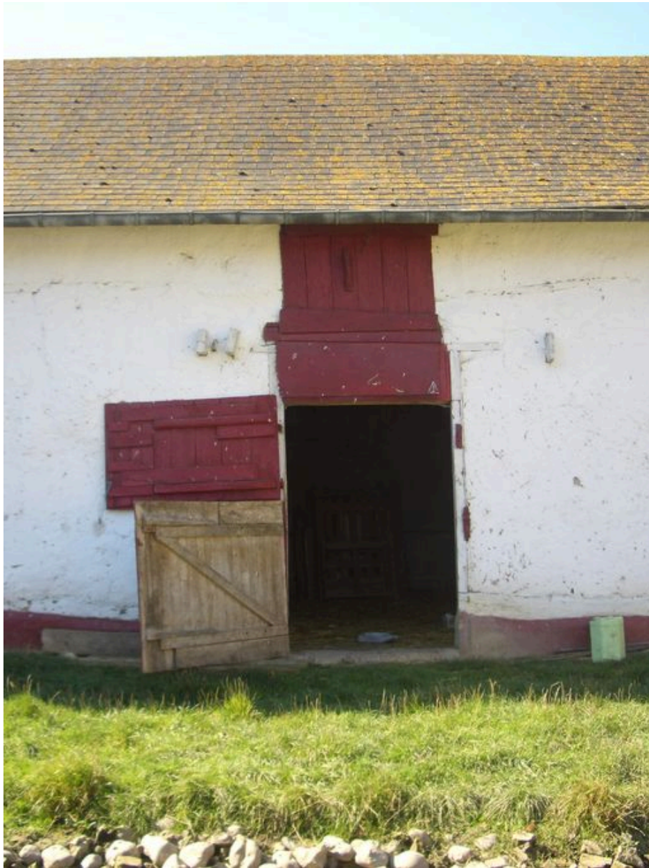
Vue d'une porte à doubles vantaux horizontaux et ouverture coulissante.
