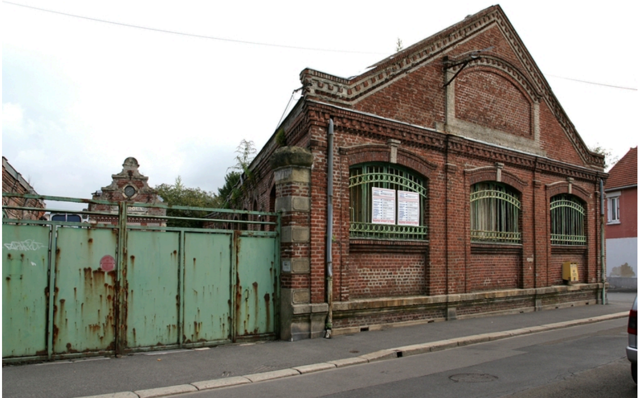
Entrée de l'usine et pignon des magasins reconstruits en 1919-1920.
