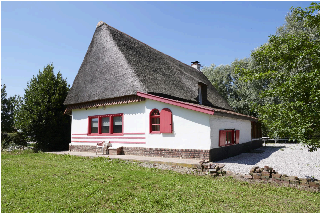
Pignon est et façade nord.
