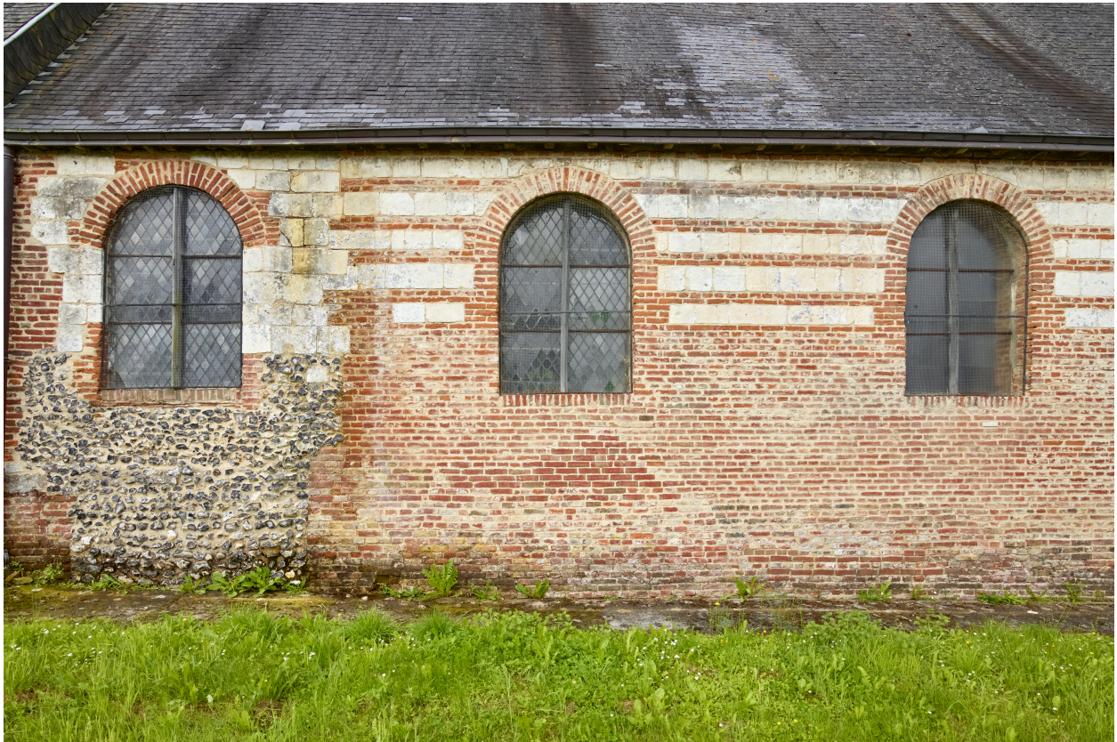
Détail de l'élévation extérieure du collatéral est.
