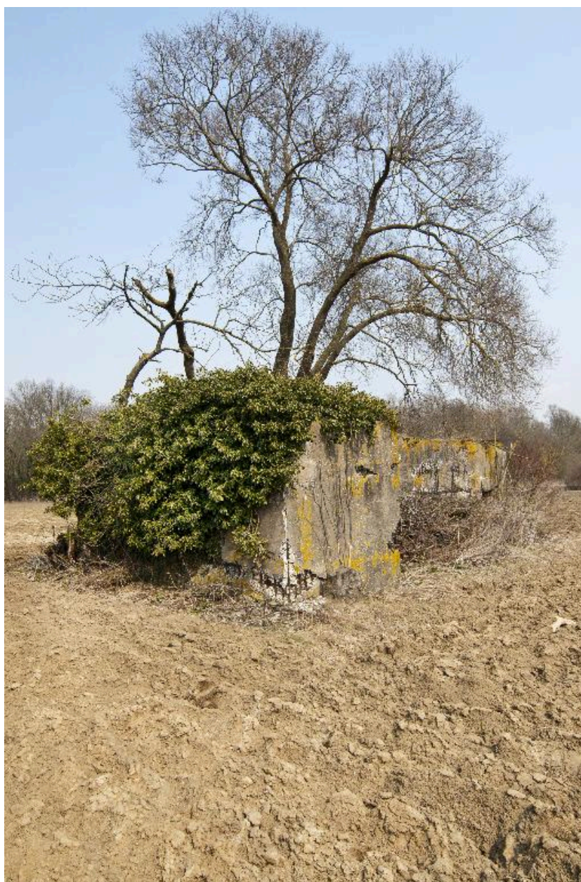
Vue générale vers le nord-est
