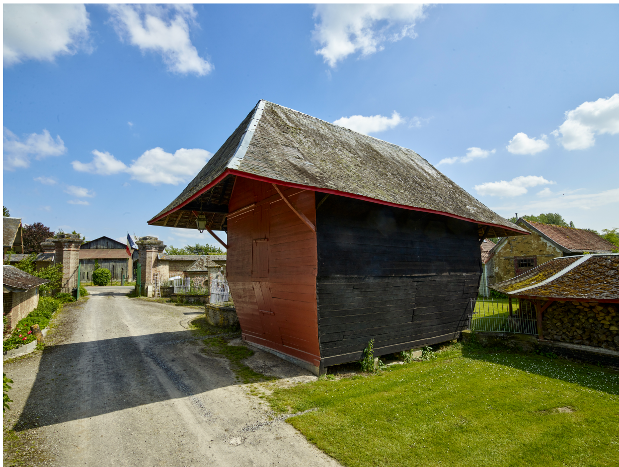
Grange, depuis le nord-ouest.
