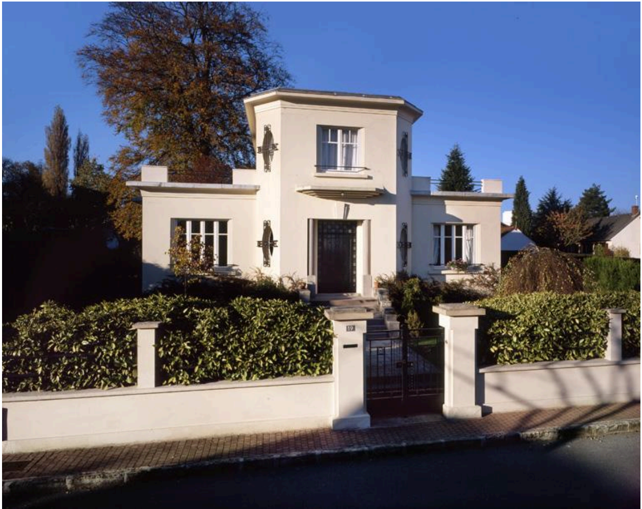
Vue de la façade sur rue.
