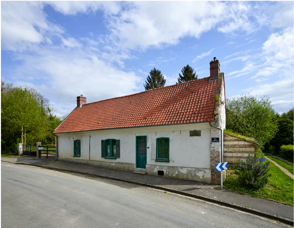
Maison, depuis le nord-ouest.
