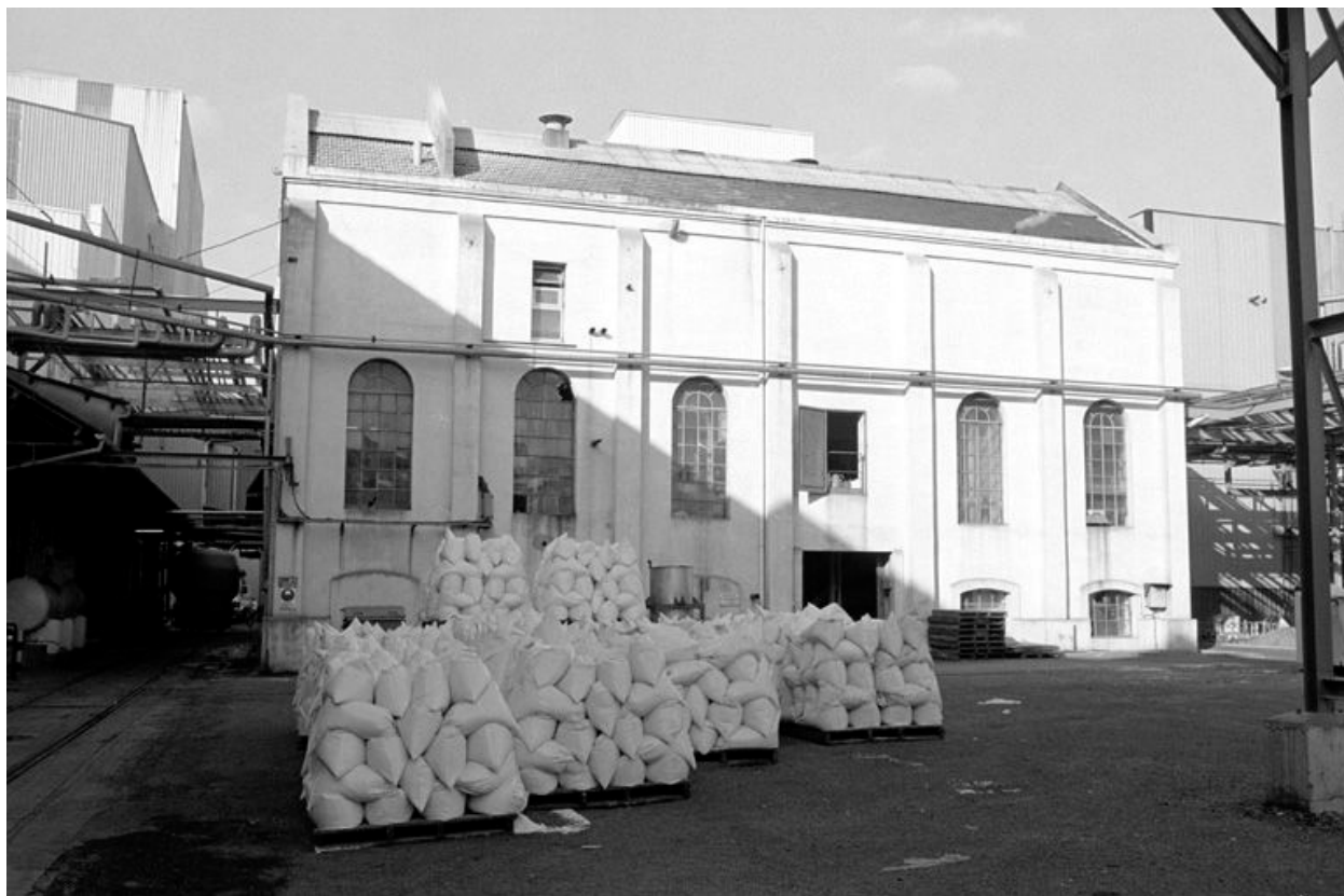
Atelier de fabrication, flanc sud.
