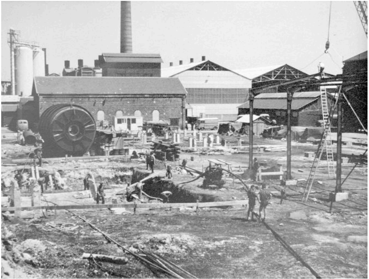
Constuction de bâtiments (AP).
