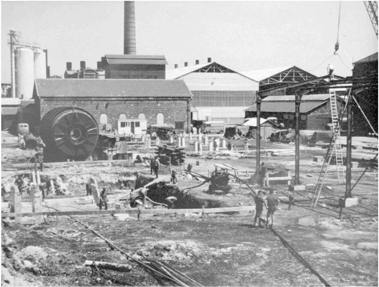
Constuction de bâtiments (AP).
