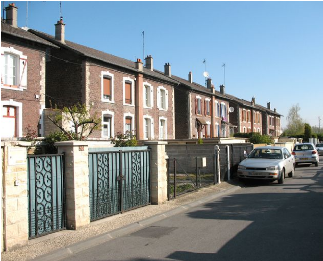
Barre de logements ouvriers de la cité Mertian.
