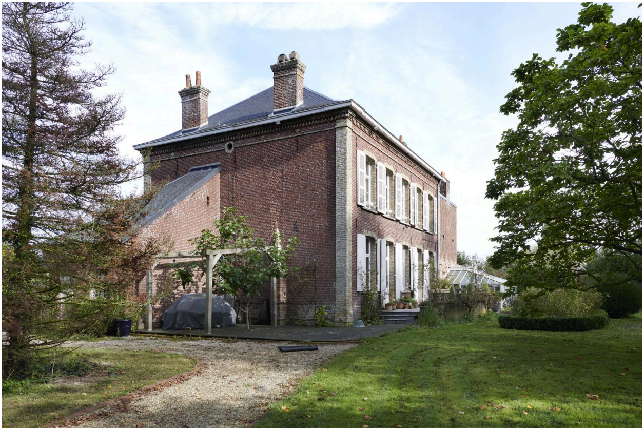
Module ouest. Pignon et façade sur jardin.
