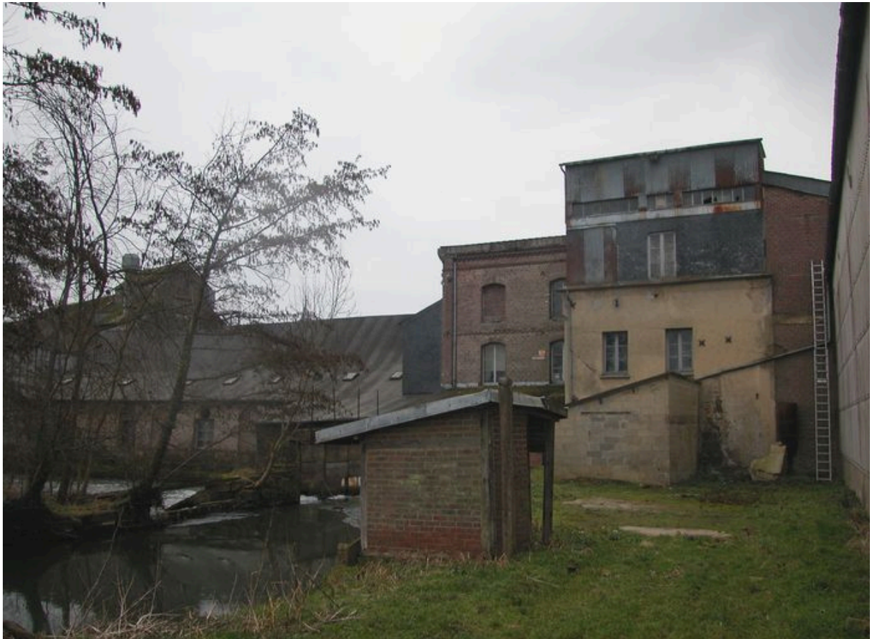
Vue d'ensemble postérieure de la minoterie.
