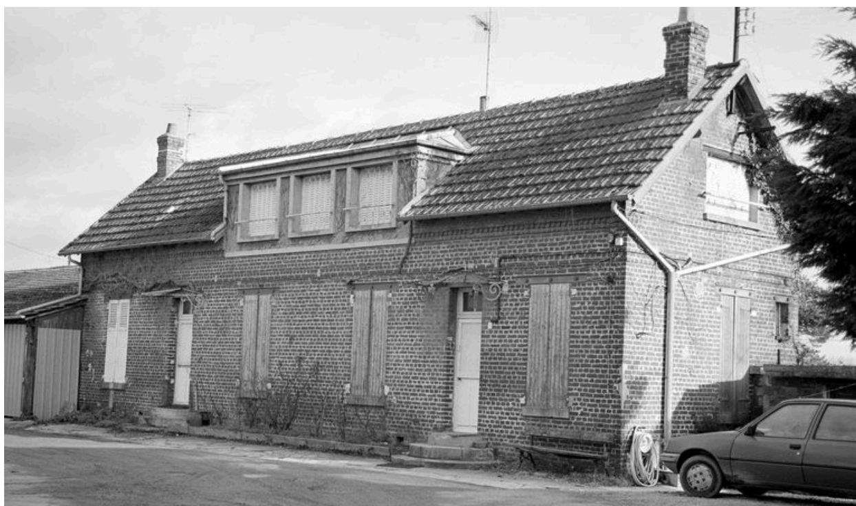
Logement de contremaître : façade sur cour.
