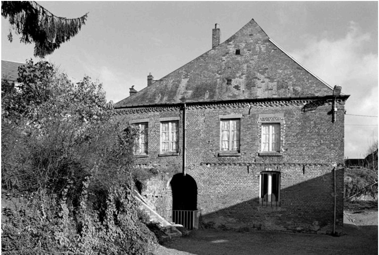
Vue de la façade occidentale, depuis la rue des Tanneries.
