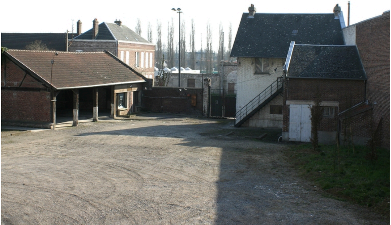
Logement et hangar industriel, 17bis boulevard Victor-Hugo (photographiés depuis la rue Félix-Faure).
