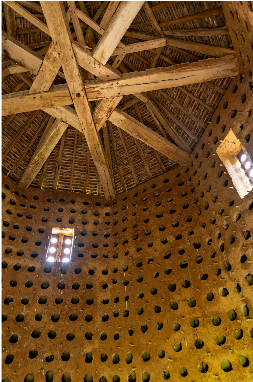
Vue intérieure du pigeonnier : boulins.
