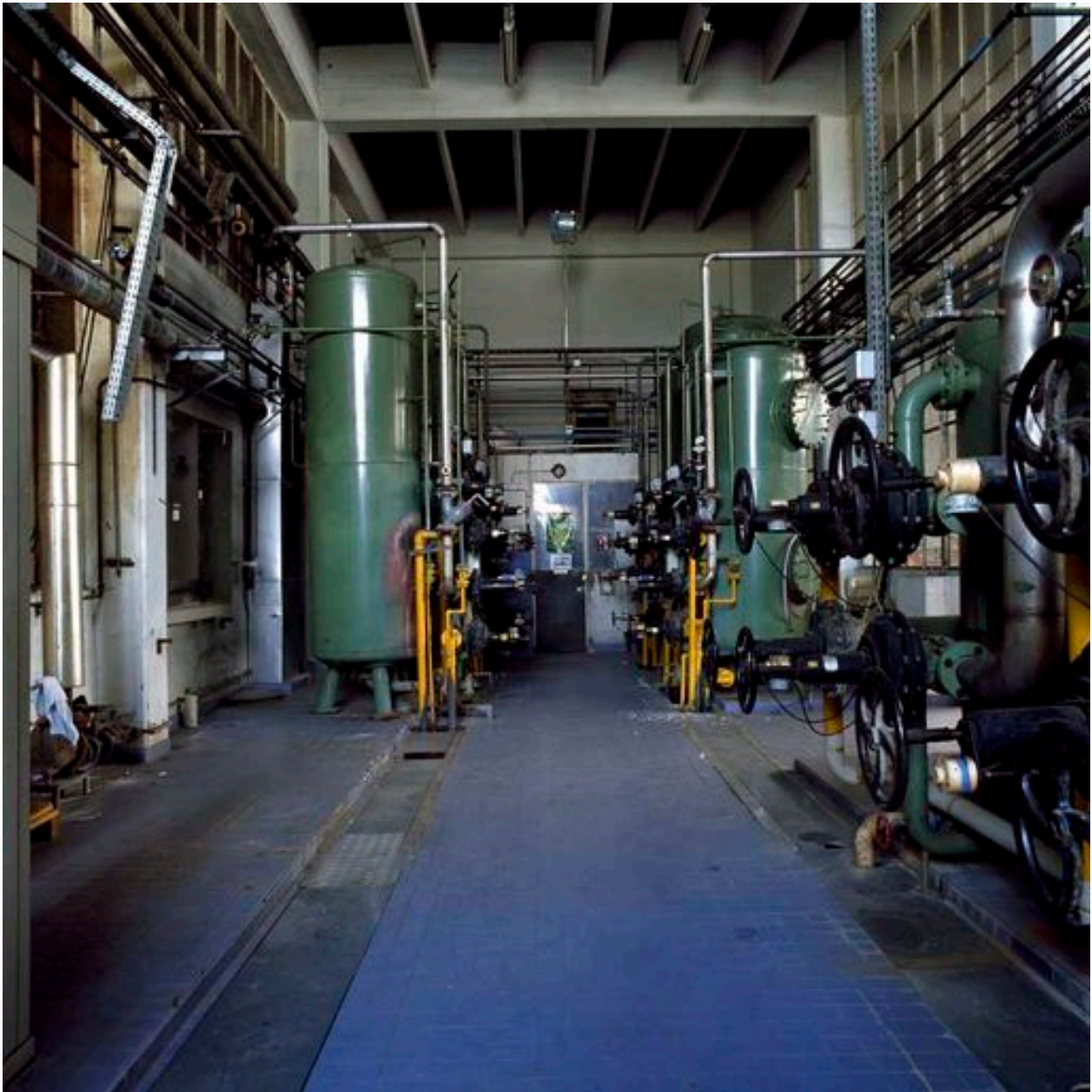
Chaudière au premier étage de la centrale.
