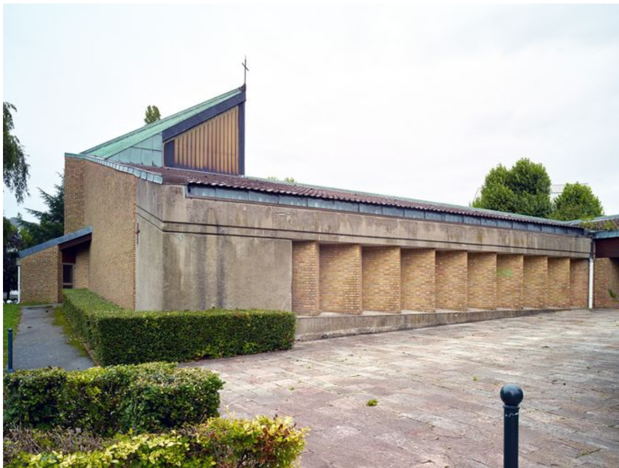
Élévation ouest de l'église.
