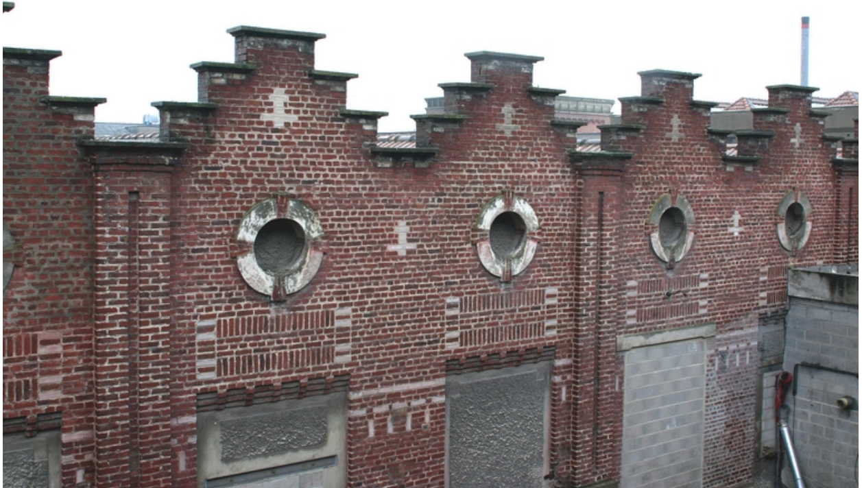
Façade sur cour des ateliers de 1921.
