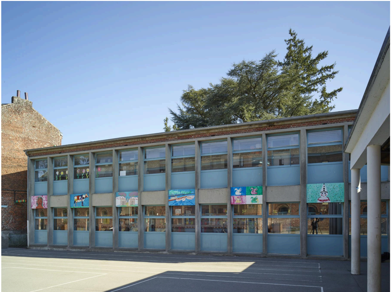
École de garçons : façade sur cour de l'aile construite dans les années 1960 le long de la rue Chevray. Vue orientée nord-ouest/sud-est.
