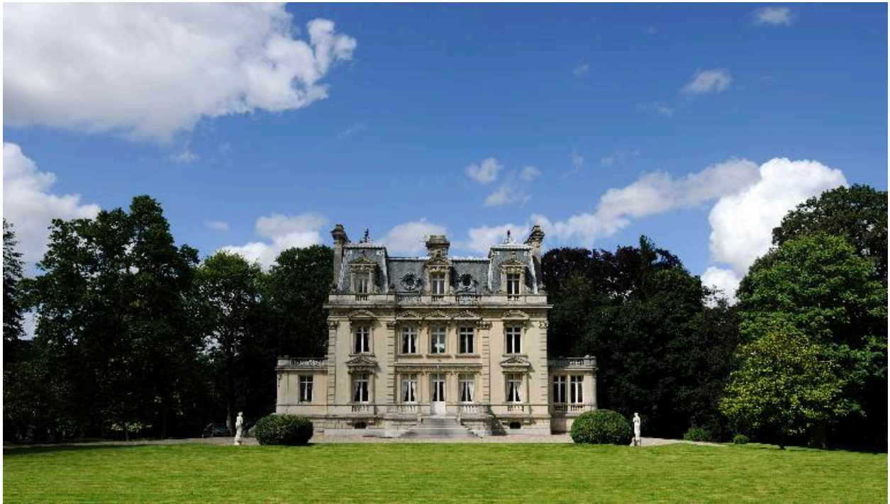
Façade arrière du logis sur parc.
