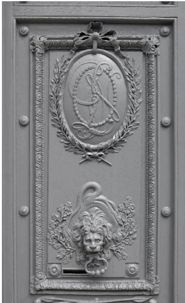
Détail des ornements – chiffre de Gaillon et heurtoir surmonté d'un mufle de lion – de la partie centrale des vantaux de la porte cochère.
