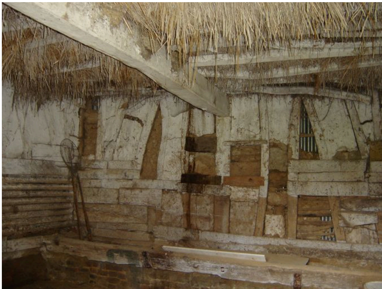
Vue intérieure des étables.
