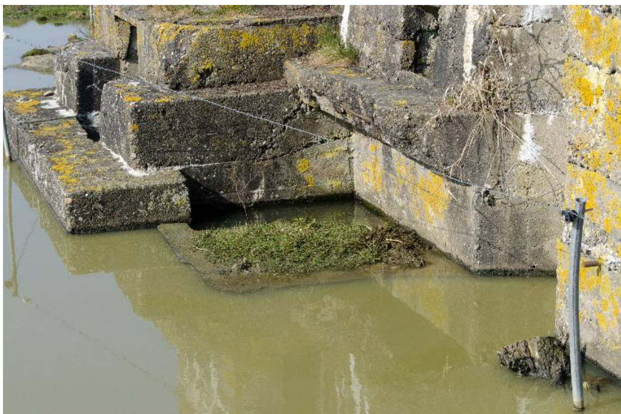
Elévation sud. Détail d'un puisard
