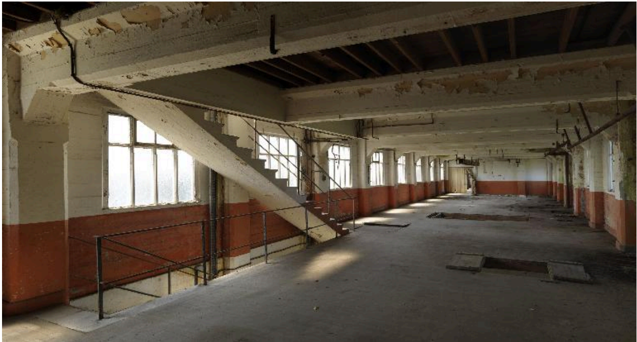
Intérieur du grand atelier du 3e étage de la minoterie.
