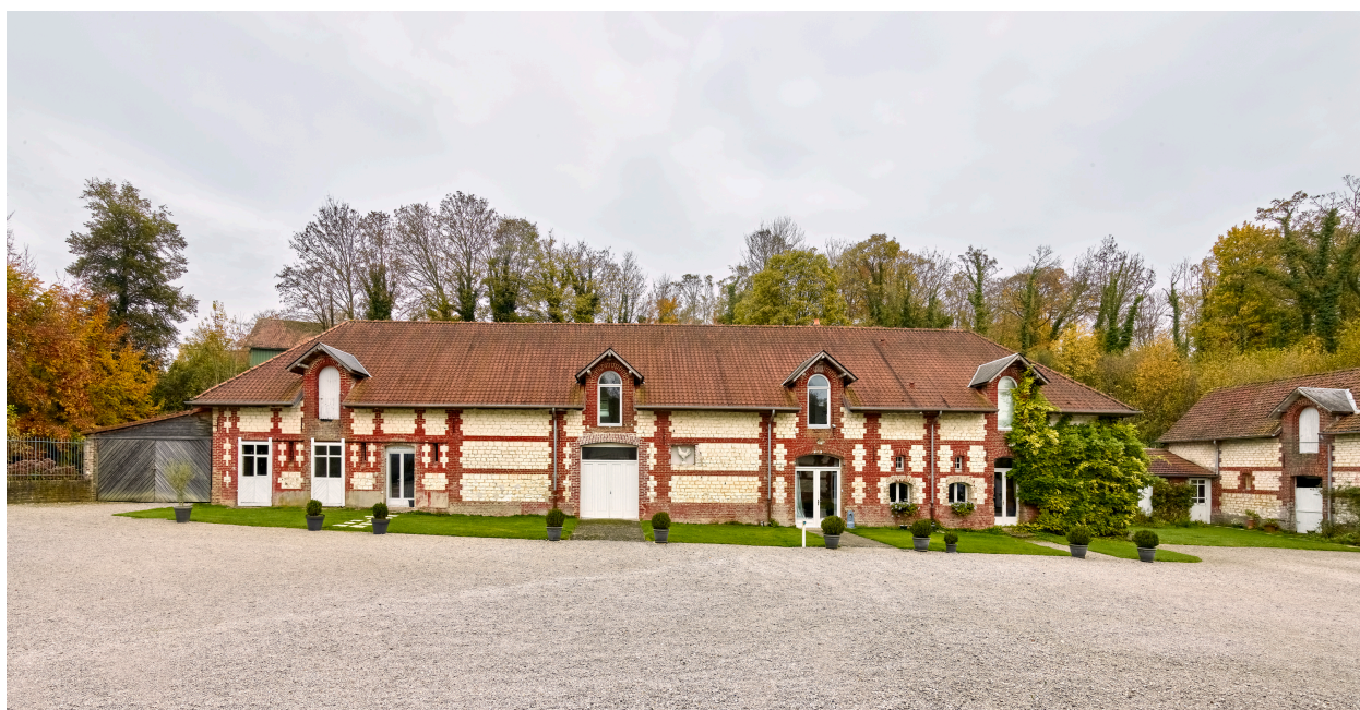
Vue de l'ancienne étable, depuis la cour.
