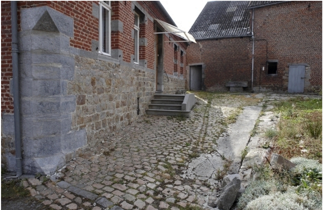
Détail du soubassement du logis.
