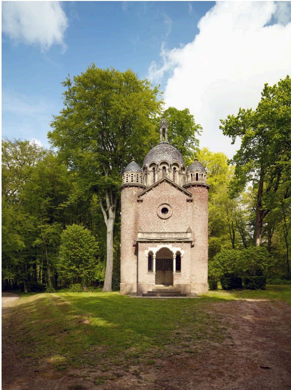
Vue générale de la chapelle Notre-Dame de la Salette depuis le chemin des Rives. (vue depuis l'ouest)
