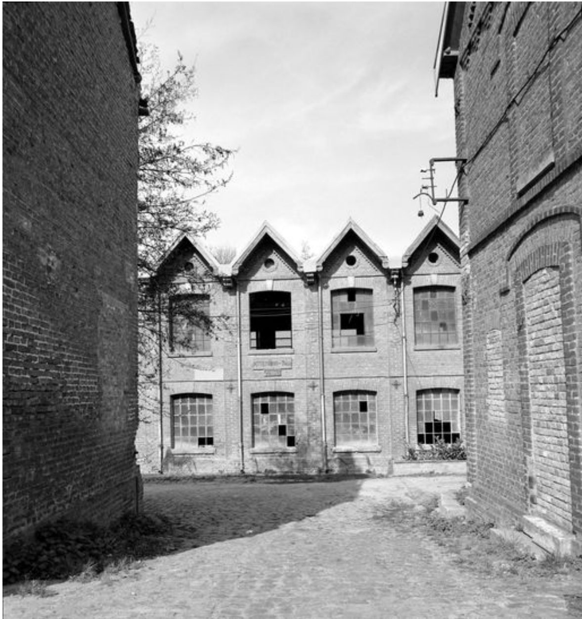
Ateliers de fabrication, flanc est détail.
