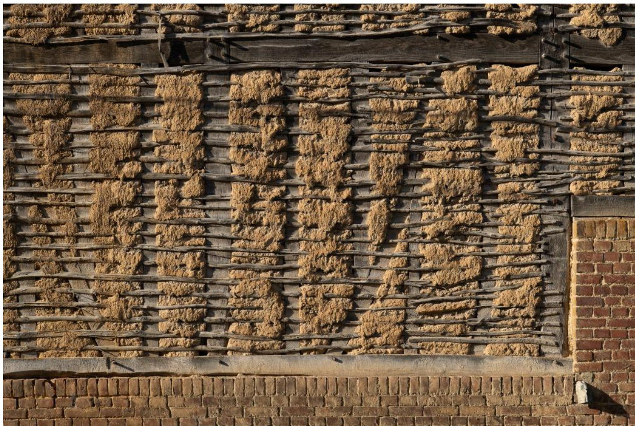
Détail de mise en œuvre des maçonneries de la grange (pan de bois, torchis et clayonnage sur solin de brique), n°7 rue d'Empire.
