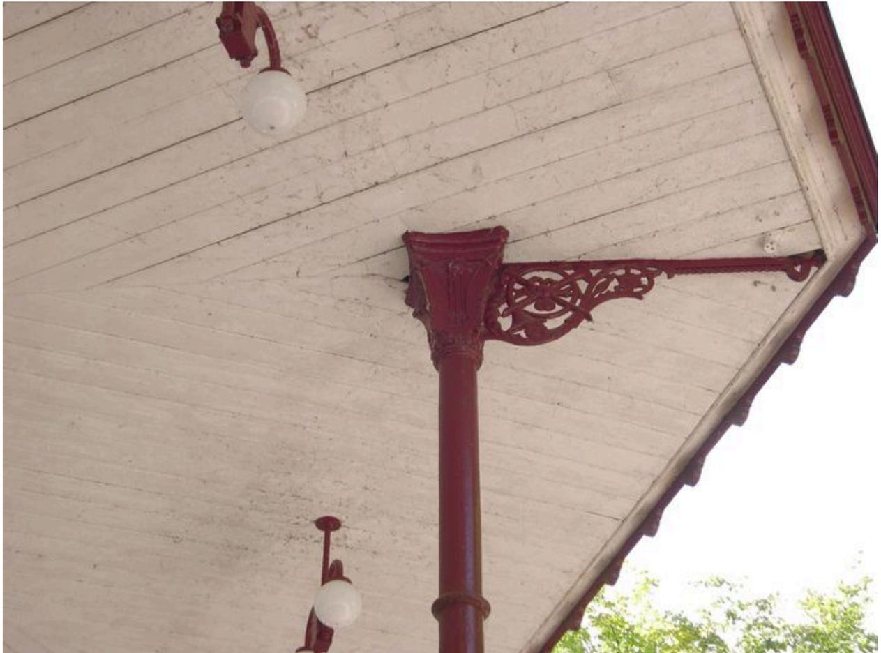
Détail : couverture et éléments porteurs en fonte.
