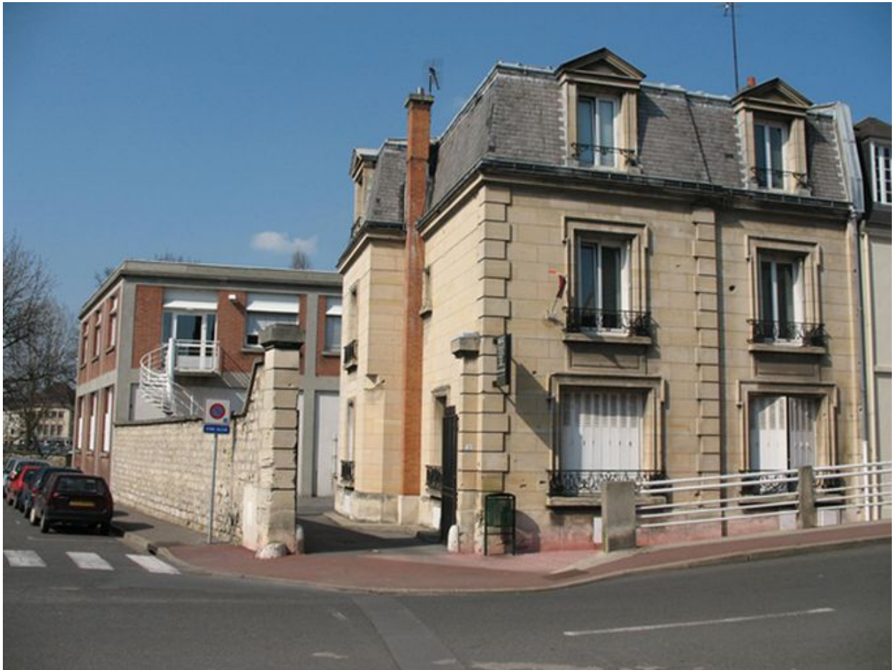
Bâtiments administratifs des établissements Willot.
