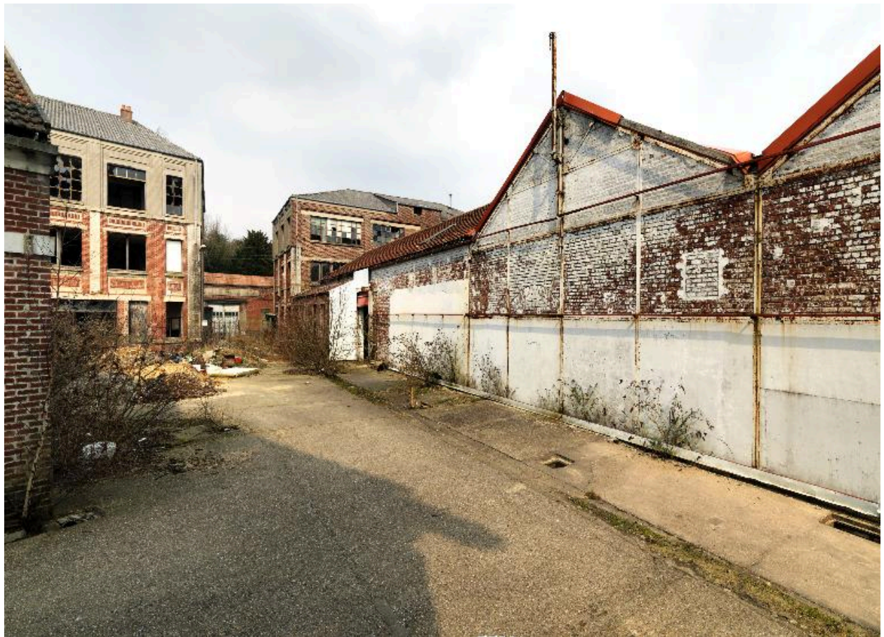
Vue d'ensemble du nord du site industriel.
