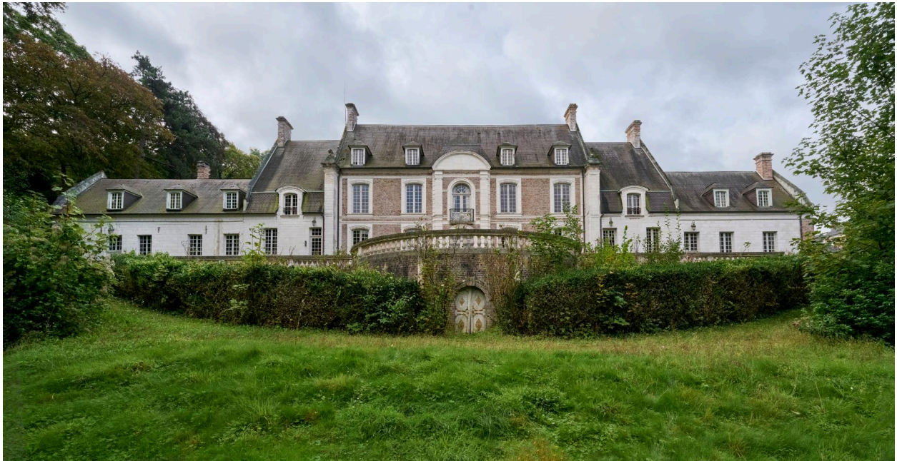
Vue générale du château depuis le nord.
