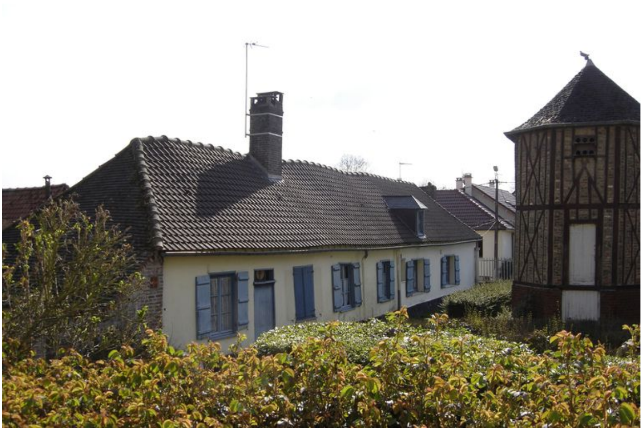
Vue des dépendances du nord depuis la cour.
