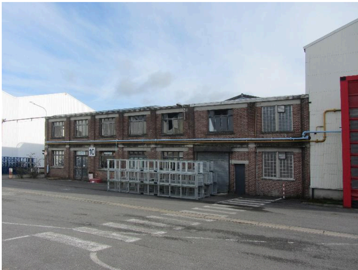
Vue d'ensemble de l'atelier de maintenance.
