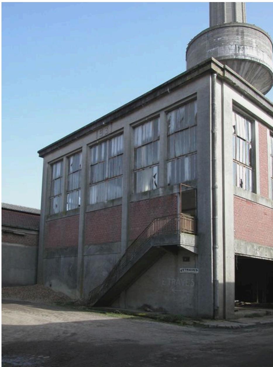
La chaufferie, façade portant la date de 1931.
